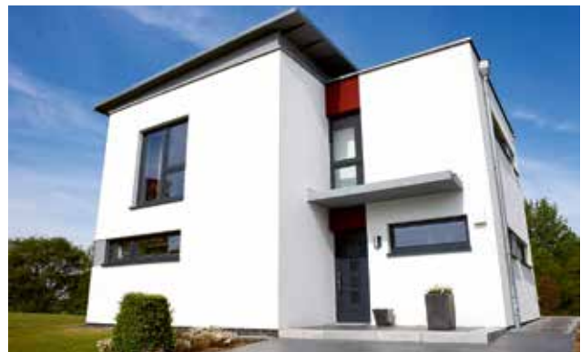
1 | Die Übergabe des Objekts an den Auftraggeber ist eine der zentralen Aufgaben der Bauleitung.
