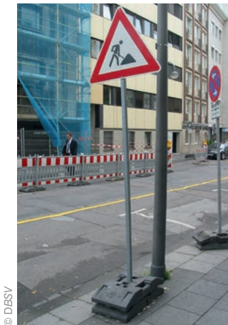
3 | Die Unterkante von Baustellenschildern sollte vom Gehweg einen lichten Abstand von mindestens 2,30 m aufweisen.
